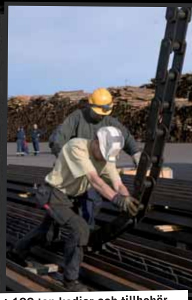
20 montörer från Kedjeexperten arbetade 5 dygn med att byta ut 100 ton kedjor och tillbehör.
